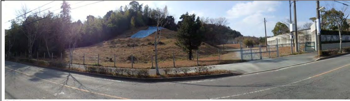
[1] 東入口を見る
