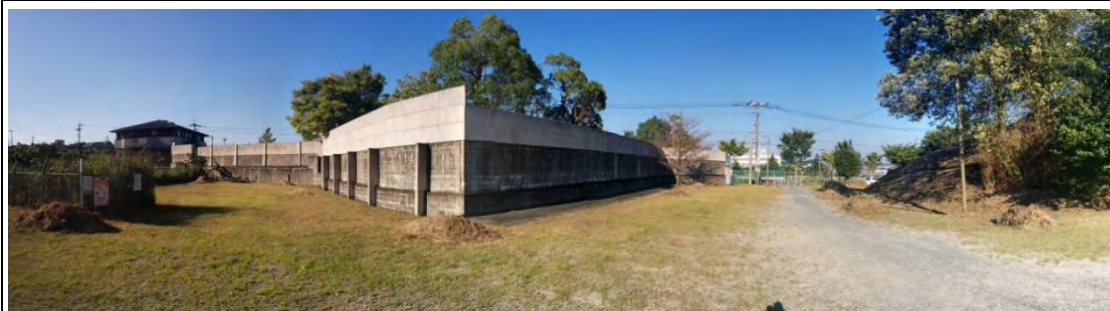
[6] 計画地内から北側小田浦池及び東側入口を見る：隣地（民家）との境界部はH=4.0m程度の壁が設けられている。写真左側の空地は池管理のため、本計画地整備後も動線を確保する必要がある。
