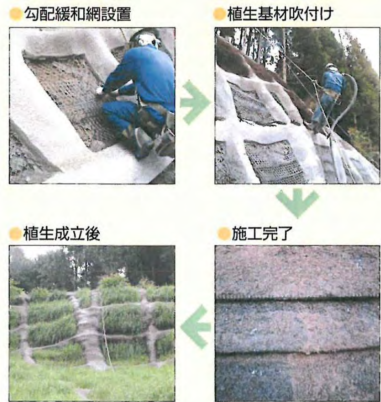
施工イメージ
