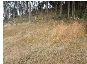
写真 2-45 東側樹林地との境界部切土
