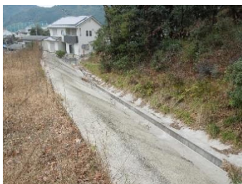
写真 2-43 北側樹林地側の盛土
