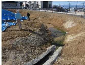
写真 2-51 敷地中央西側付近の排水路
