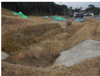
写真 2-50 敷地内の調整池
