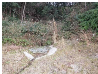
写真 2-48 敷地中央部の仮排水路
