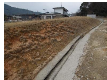
写真 2-42 仮設道路沿いの盛土
