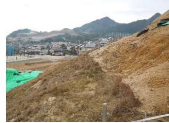
写真 2-55 敷地内の種子吹付
