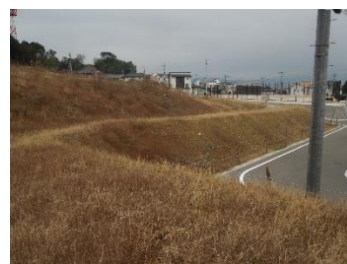
写真 2-41 道路沿いの盛土
