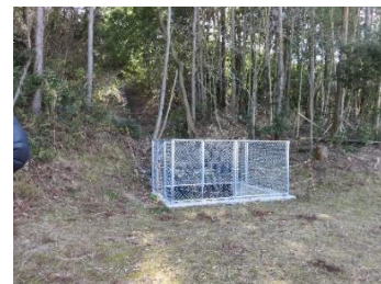
写真 2-49 敷地南側の集水枡
