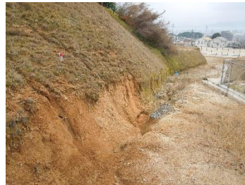
写真 2-44 崩落法面
