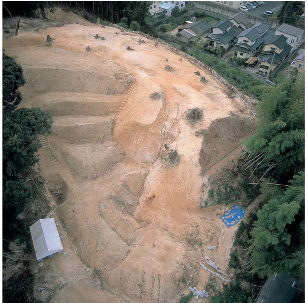
(1) 調査地全景 (北東から)
