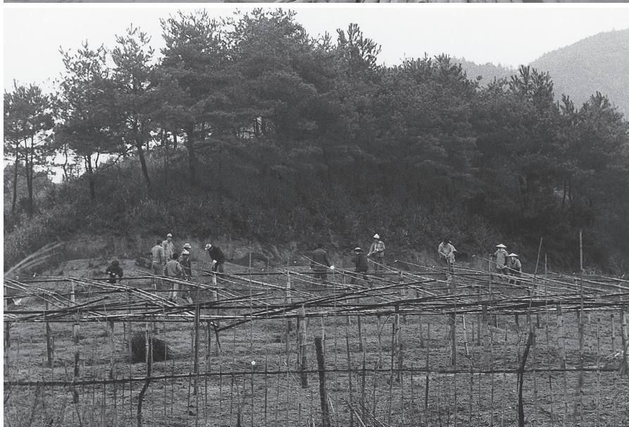
(3) 乙金窯跡調査風景（南から）
