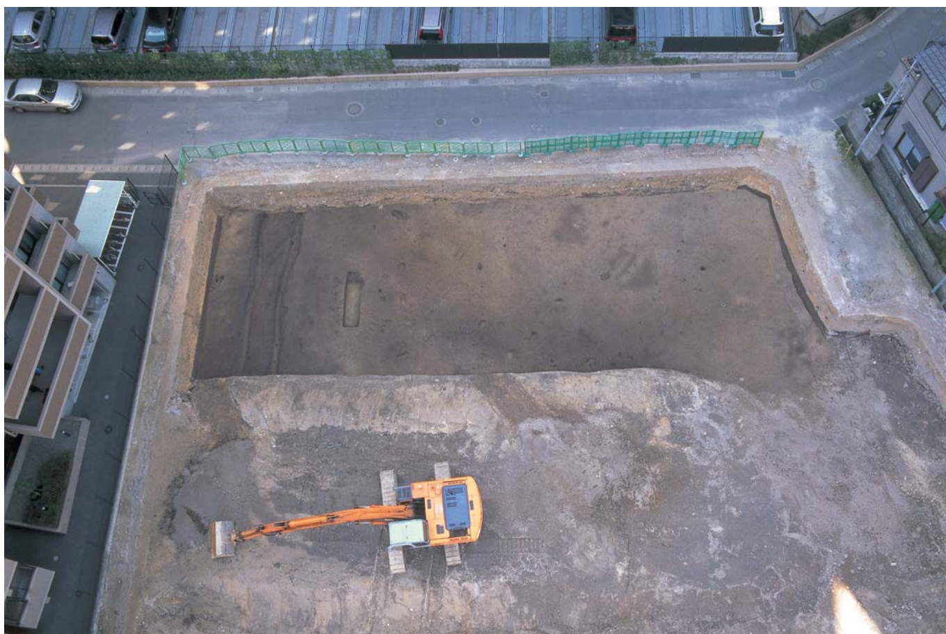
(2) 御供田遺跡第6次調査地西半部全景② (北東から)
