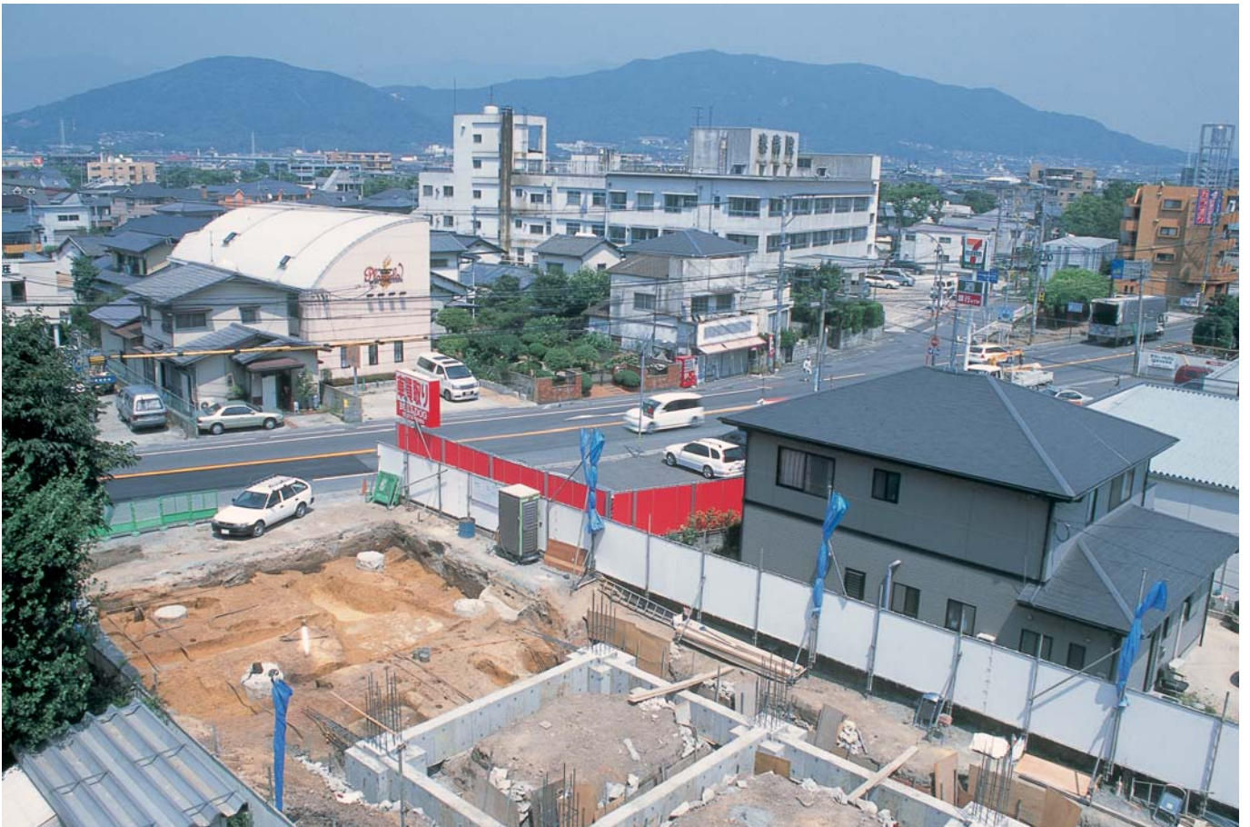
(2) 第3次調査区遠景 (四王寺山を望む) (西から)
