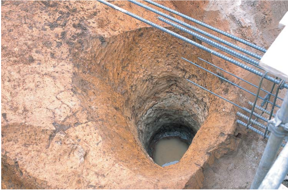
(1) SE01完掘状況 (西から)
