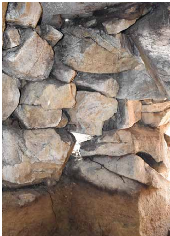
(1) 1号墳玄室右側壁玄門側隅部（北西から）
