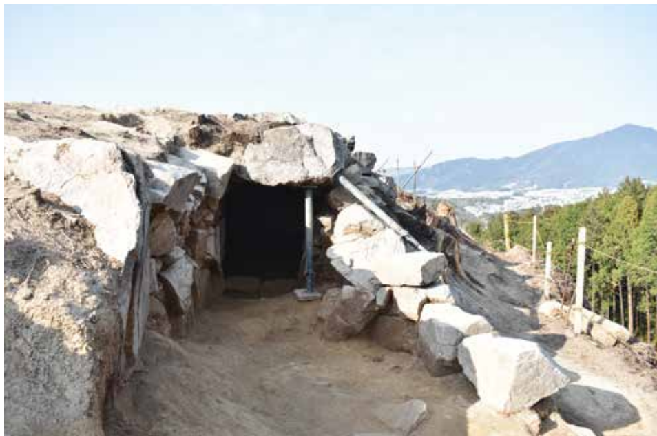
(1) 1号墳羨道検出状況 (南東から)
