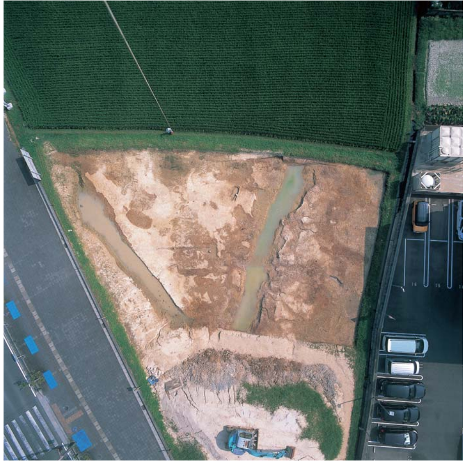
(1) I区俯瞰写真(上が北)
