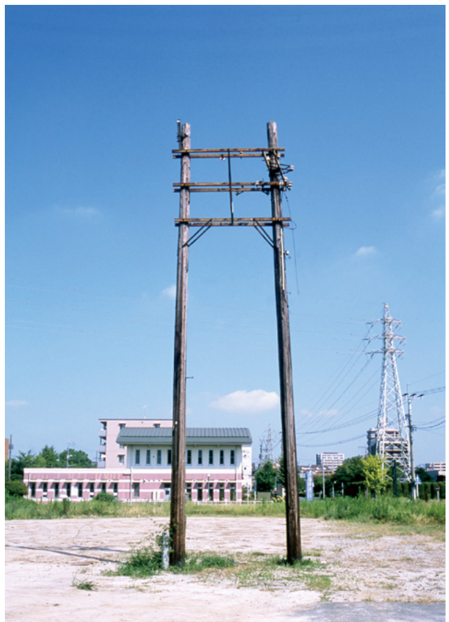
(3) 木製鳥居型電柱A（南から）
