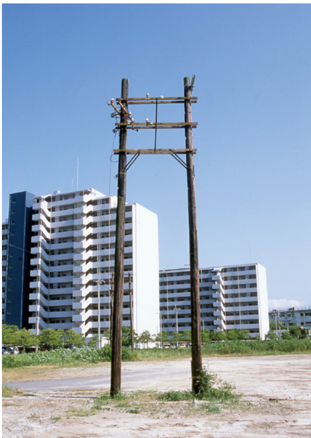
(2) 木製鳥居型電柱A（北から）
