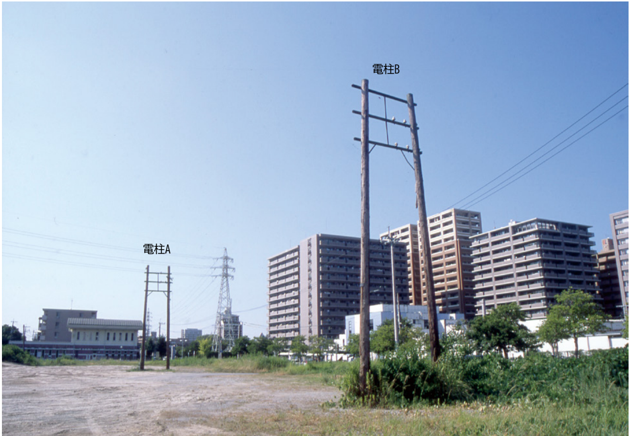
(1) 木製鳥居型電柱（南西から）
