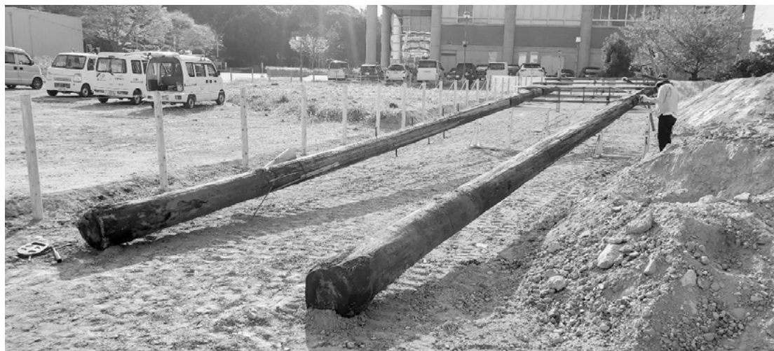
木製鳥居型電柱（右：電柱A-1 左：電柱A-2）
