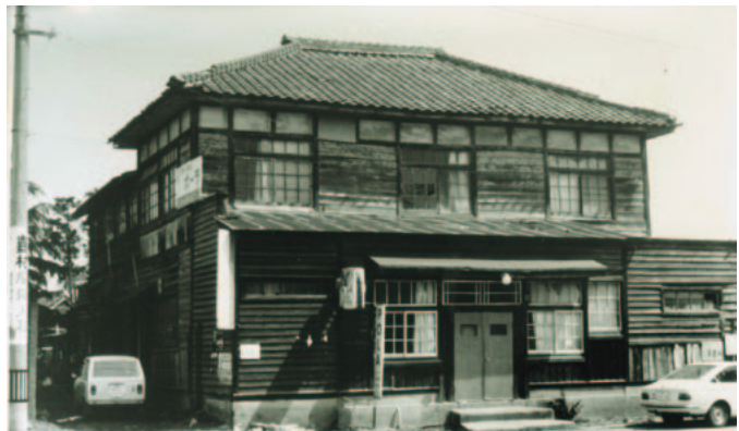
写真5 筒井の局舎前の道路拡幅のため立退くことになり、国鉄雑▶ 餉隈駅（現JR南福岡駅）近くに 移転改築した。
