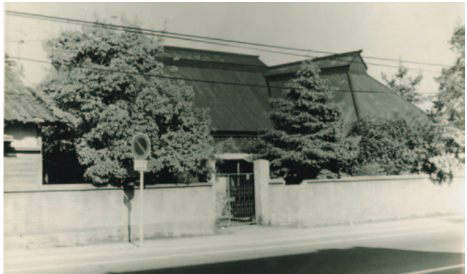
写真1 創業時の局舎として使用した 城戸家 ▶
