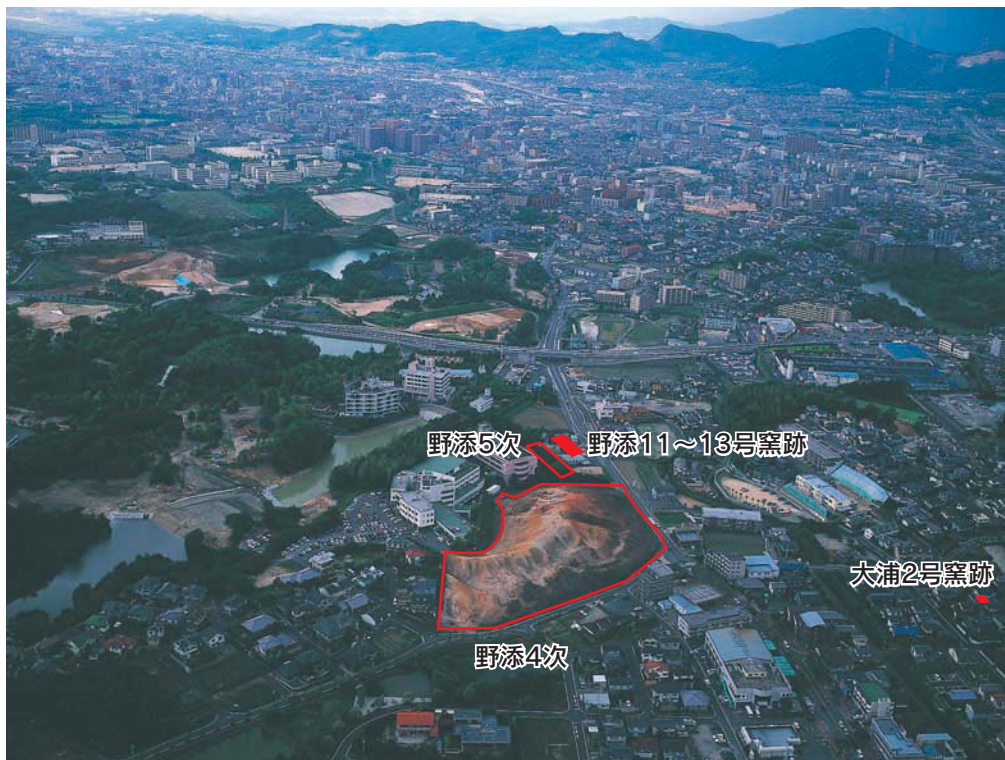
上大利地区の瓦出土遺跡
